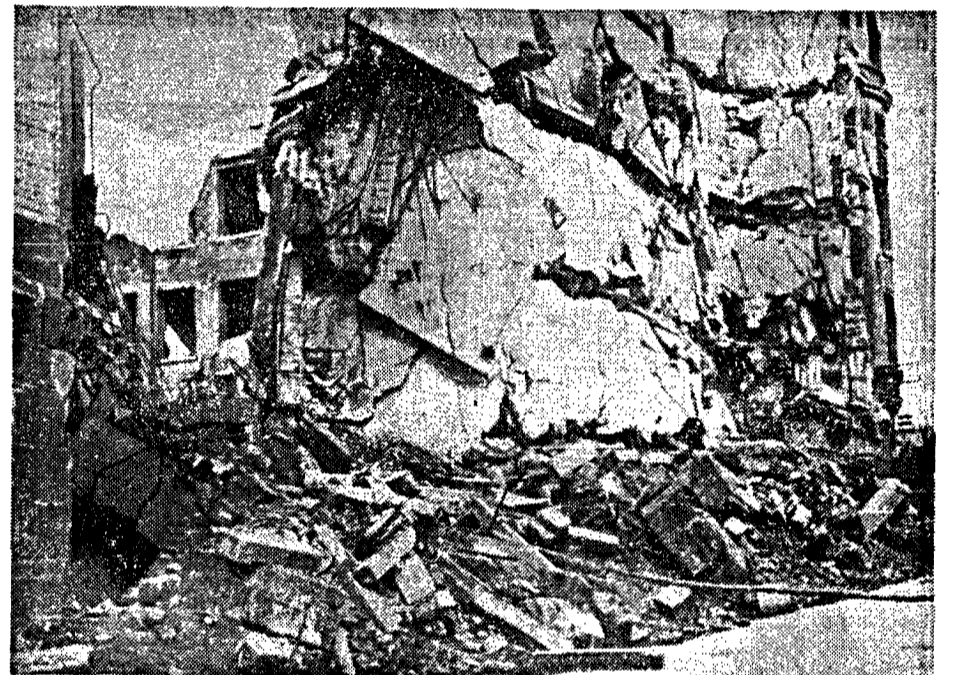
VÖLLIG ZERSCHLAGEN von den Bomben kurz vor Kriegsende war das Verlagsgebäude; unser Bild zeigt die Trümmerfront entlang der Poststraße...
